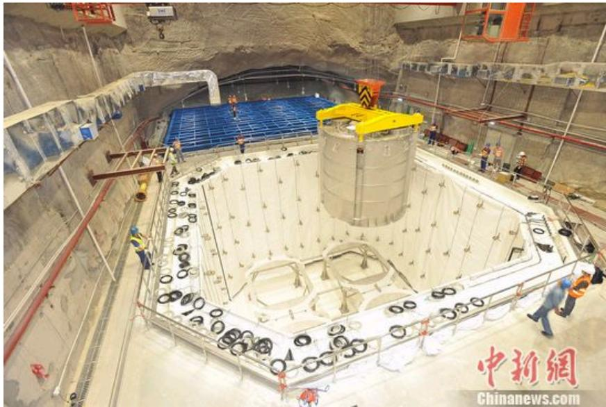
3号实验厅中, 110吨重的中微子探测器正在吊装入10米深的水池中。凤凰卫视供图
