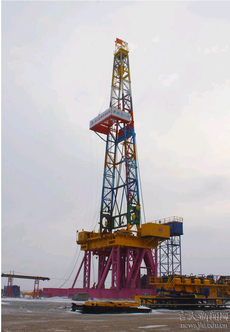
钻机组装完毕，高60米，占地10000多平方米 摄/建设工程学院
