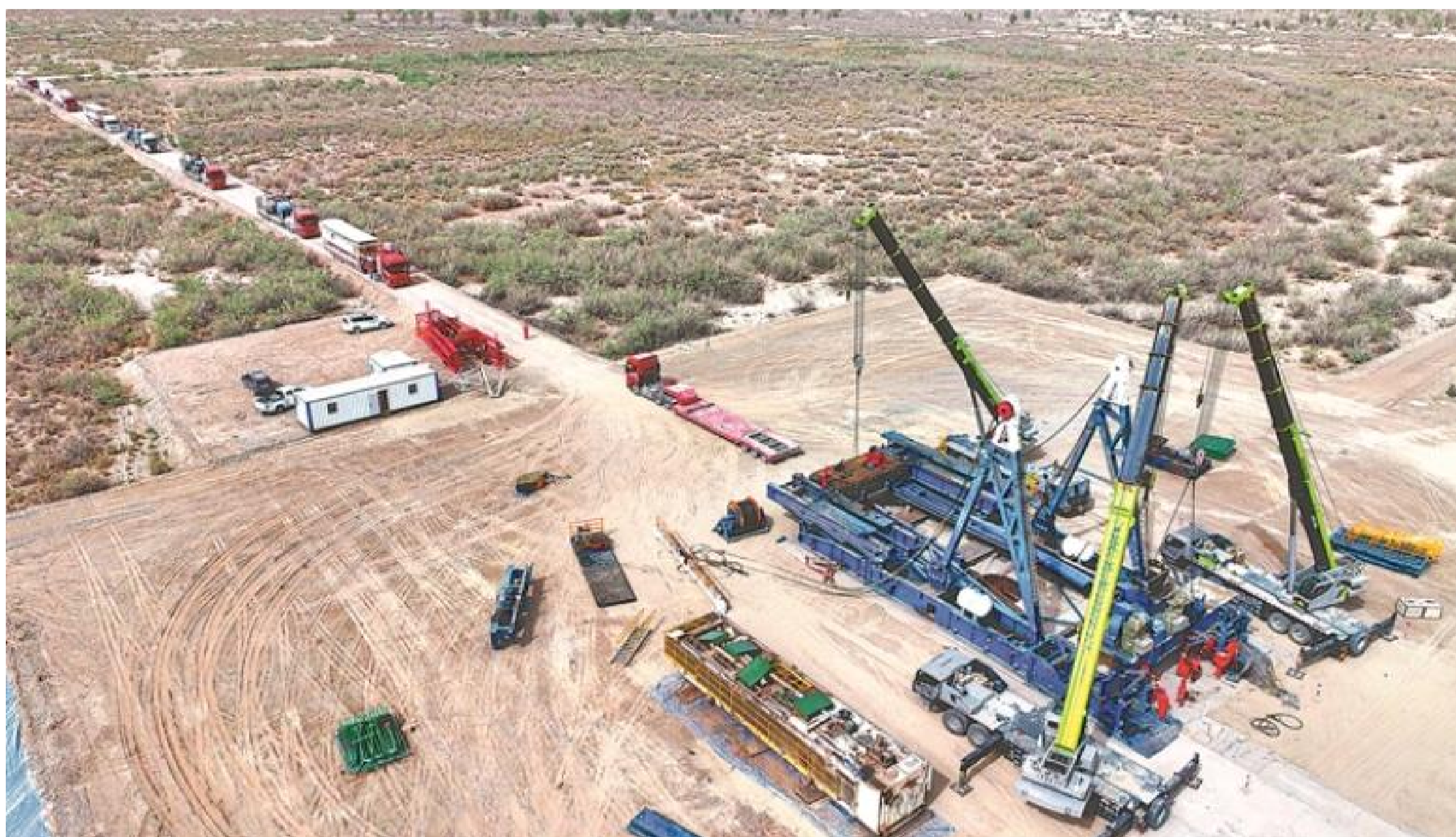
图为哈13-H9井搬迁作业现场。
