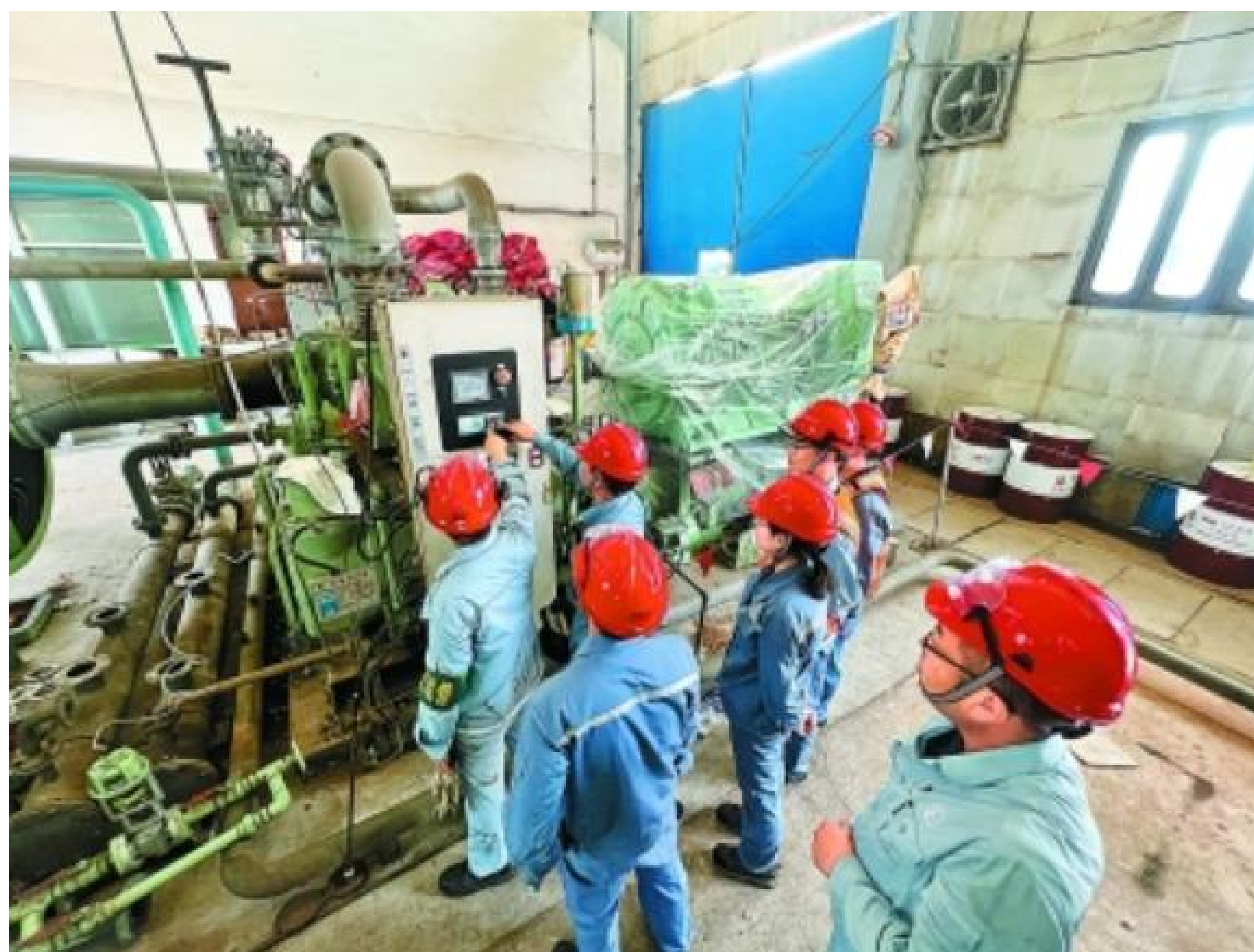
高桥石化员工调试苯酚-丙酮装置设备。
