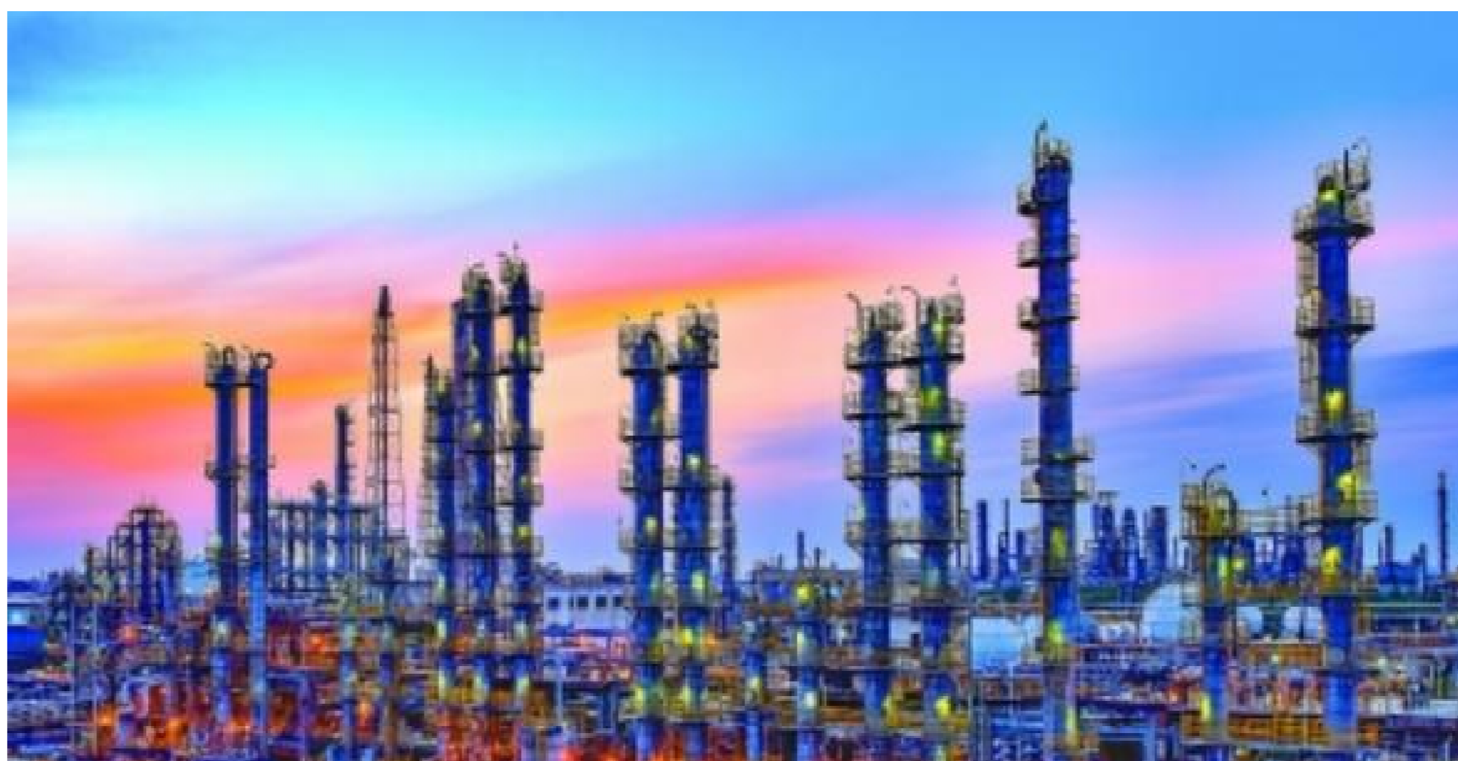
上海石化异戊二烯生产装置。
