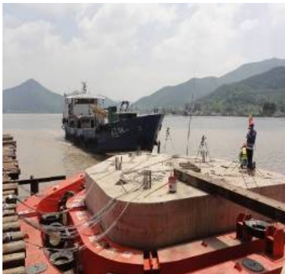
图1 实船撞击桥墩防撞装置实际布置图
