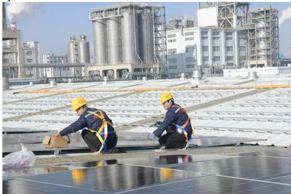
中天合创采用分块发电、就近并网方式，在聚乙烯仓库屋顶建设分布式光伏发电项目。该项目计划于12月中旬建成并实现并网发电，预计每年可供绿电620万千瓦时，所发绿电用于企业生产。图为该光伏发电项目建设现场。姚宁 摄
