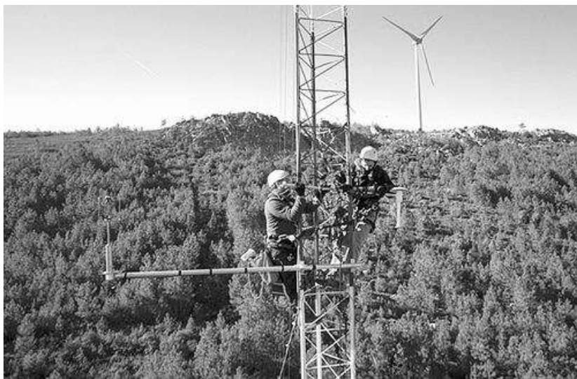
技术人员正在安装传感器。图片来源: smart-box.pt
