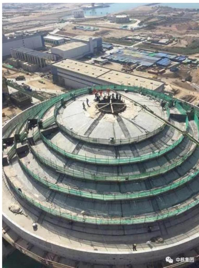
当地时间4月10日，华龙一号海外首堆巴基斯坦卡拉奇核电K2核岛外层安全壳穹顶最后一层混凝土浇筑完成，圆满实现结构封顶，至此华龙一号海外首堆高度达到73.98米。
