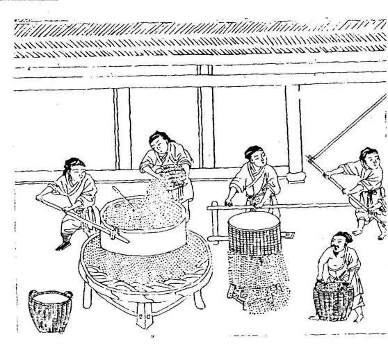
图为元王祯《农书》描绘的砻磨。"砻"字出现于东汉,初为石质,宋元后以土、木、竹为原料,以人力推动,用于谷物脱壳。 《农书》记载: "编竹作围,内贮泥土状如小磨,仍以竹木排为密齿,破谷不致损米。就用拐木穷贯砻上掉轴,以绳基檩上,众力运肘转 之,日可破谷四十余斛。"砻磨采用曲柄连杆机构,即在卧式木柄上凿一孔眼,在孔眼中插以带拐的丁字形连杆,连杆的另一端另接拐 木,连杆与横木也成为丁字形,横木两端系以绳索,挂于梁上,人推动横木,就可以将丁字形杆的直线往复运动变成砻磨的旋转运动。来 源: (元)王祯.农书-农器图谱九-杵臼门.清光绪二十一年(1895)武英殿聚珍版增刻本
