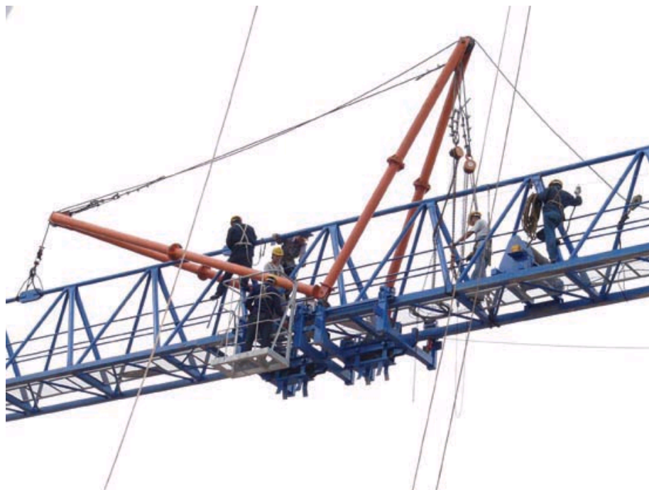
图4 STT293空中拆卸顺序及使用机具
