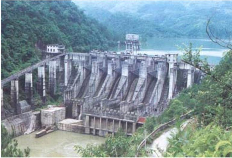
池潭水电站位于福建省泰宁县，是闽江支流金溪干流的龙头站，也是开发金溪水能资源的第一期工程。工程以发电为主，防洪、航运、养鱼等综合效益。电站装机容量10万千瓦，年发电量5亿度。以一回220千伏和两回110千伏电压出线接入闽北电网
