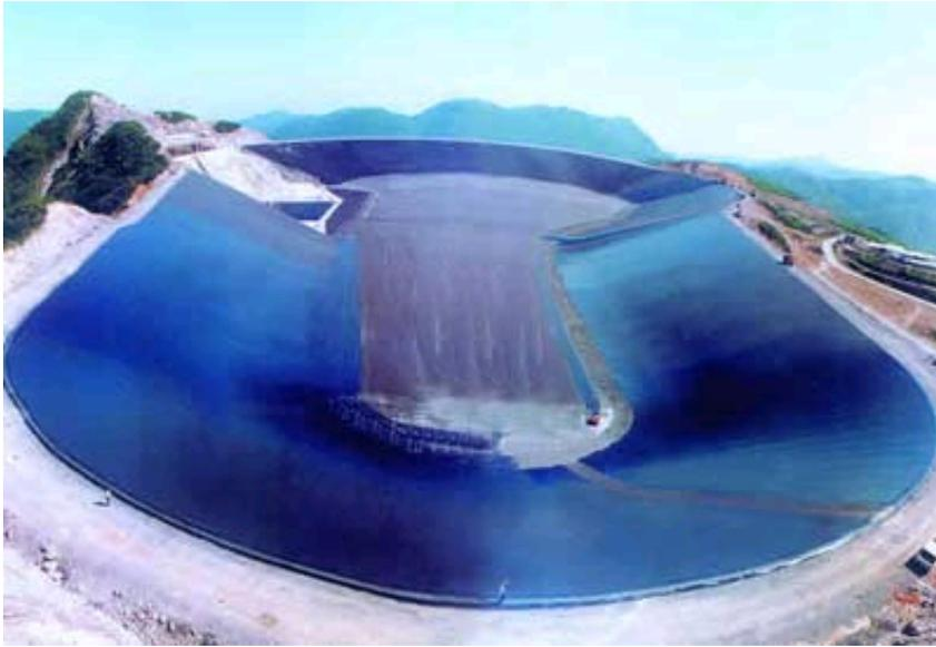
天荒坪抽水蓄能电站位于浙江省安吉县境内，距上海175km、南京180km、杭州57km，接近华东电网负荷中心。电站装机容量180万kW，上水库蓄能能力1046万kW·h，日循环蓄能量866万kW·h，年发电量31.6亿kW·h，年用电量（填谷电量）42.86亿kW·h，承担系统峰谷差3kW任务。电站设置的事故备用库容一次可向电网提供1kW·h的事故电能，担负系统事故备用和旋转备用，并可担任系统调相任务。因此，建设该电站除可使华东电网增峰能力外，还可改善火电机组的运行条件，减少全网的消耗，提高电网运行的可靠性和经济运行水平，并且有面的社会效益。
