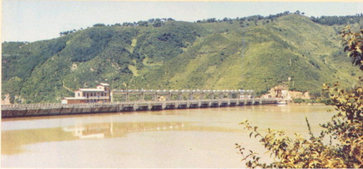
回龙山水电站位于辽宁省桓仁县城西南44km的浑江上，是浑江中下游水利资源梯级开发的第二个水电站。该工程于1966年按长隧洞方案进行勘测设计，1968年10月进行初步设计勘测工作，1969年5月15日主体工程开工。
