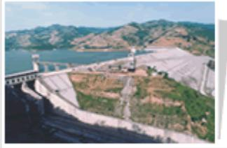
石头河水库位于中国陕西省眉县境内，黄河水系渭河南岸支流石头河上的斜峪关上游1.5km处。工程以灌溉为主，兼具发电和防洪效益。粘土心墙土石坝，最大坝高114m，水库总库容1.47亿 $m^3$ 。水电站装机容量4.95万kW，设计灌溉面积8.5万 $hm^2$ 。工程于1971年10月开工，1989年10月完工。
