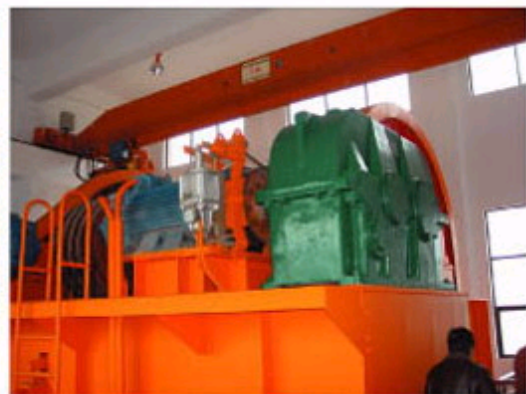
设备安装到位
