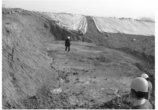
图1 单个裂隙面形成的滑面
