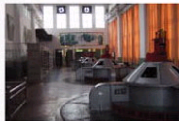
泵站站房内景
