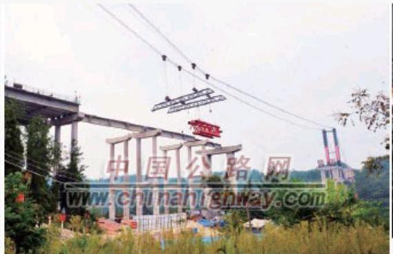
9月23日上午，张（家界）花（垣）高速公路海螺猛洞河大桥拱肋首节安装仪式在美丽的猛洞河大峡谷上举行。拱肋安装工程的启动，标志着猛洞河大桥的建设取得重大进展，开始全面进入上部永久结构施工阶段。据介绍，张花高速猛洞河大桥桥面到水面有230米高，为湖南目前最高的拱桥。
