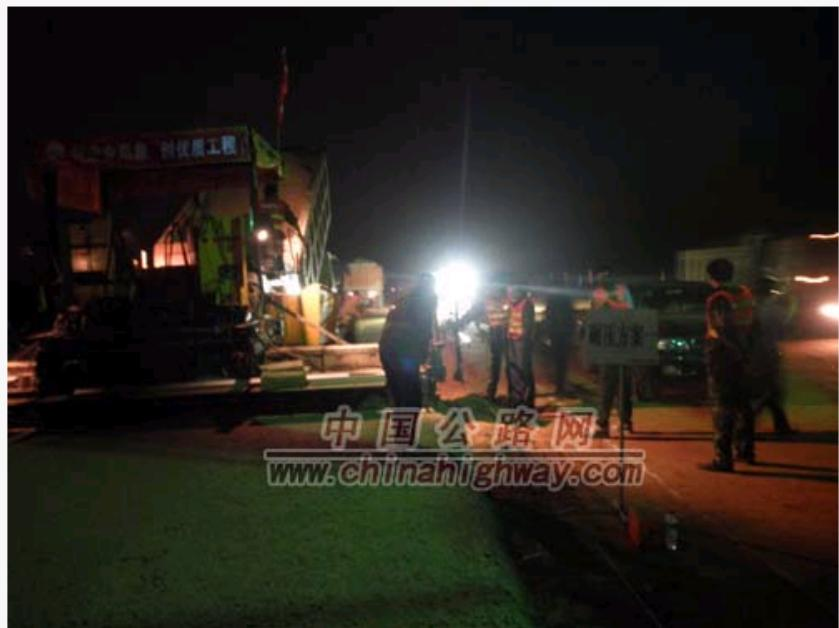
吉莲高速公路的路基工程，经过8个多月采用三次线控法标准化施工，在A5标的带动下，从11月25日起纷纷开始交验。这下可乐坏静候多时的路面施工单位。11月29日下午5时半，AP1标江苏恒基路桥有限公司项目部出动2台摊铺机、3辆振动压路机、1辆胶轮压路机、1辆水车、2台照明灯车等，在主线K23+600-K24+020处开始摊铺底基层，吹响了吉莲高速公路底基层摊铺施工号角。经过6个多小时的挑灯鏖战，30日凌晨1时顺利摊铺完毕。
