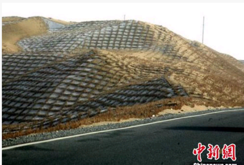
新疆塔克拉玛干沙漠公路防风固沙工程成道路安全卫士。
