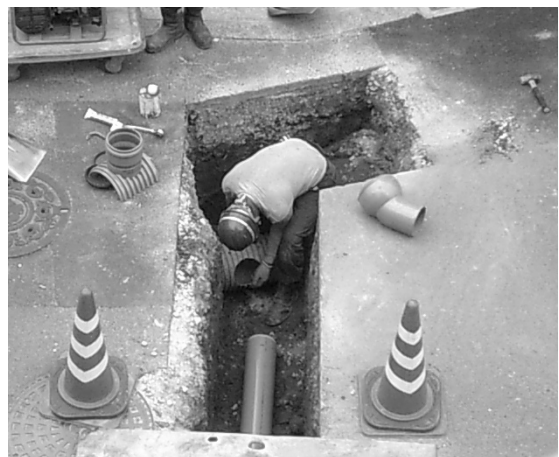
写真1 管路布設換え工事の作業状況
