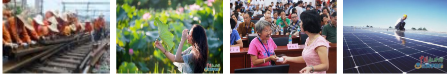
烈日下铁道工换岔忙 荷花艳 游客笑 乐安县安置房公开摇号 荒山建起光伏电站(图)
