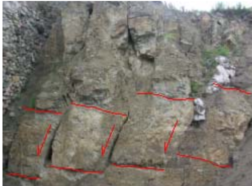
图 6 泥质灰岩岩层逐级下错破坏
