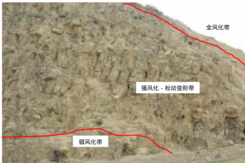
图 3 鱼复加油站泥灰岩边坡岩体风化与松动变形特征
