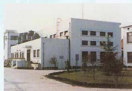
杭州长征化工厂1000kW沼气发电站
