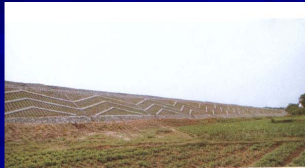
软土地段高填方路基
