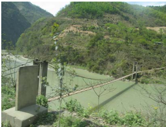
图 11 震前左岸元河坝原貌(面朝上游)
