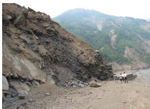
(b) 面朝通口河下游(泄流槽左岸堰塞坝似层状结构)
