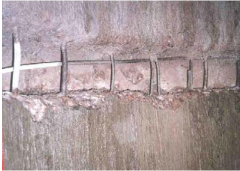
图 1 立井井筒破坏状态
