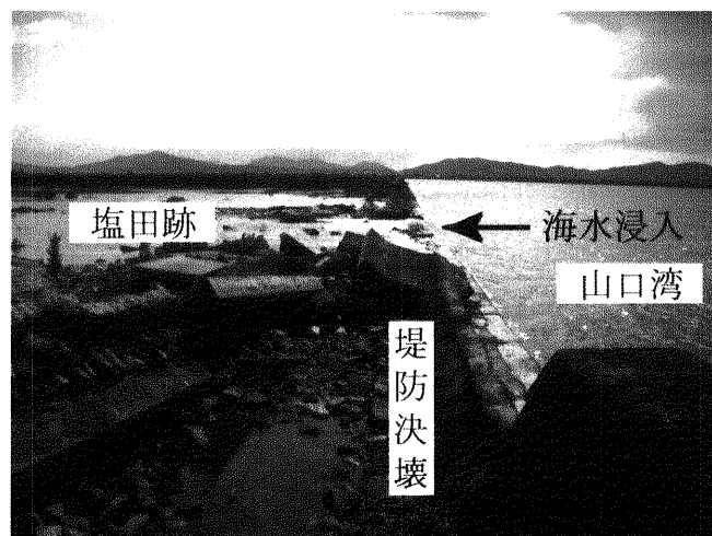
第10図 台風18号に伴う高潮による海岸堤防の決壊状況(山口県山口市秋穂二島幸崎, 1999年9月25日撮影)。
