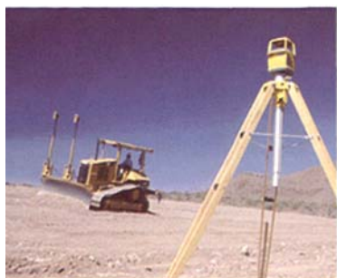
图9 安装激光找平装置的推土机施工现场
