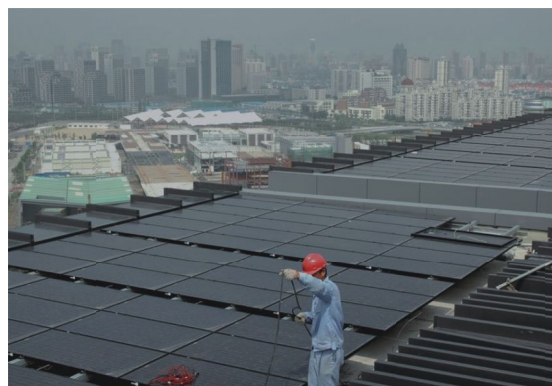
图5 中国馆中的太阳能组件安装施工
