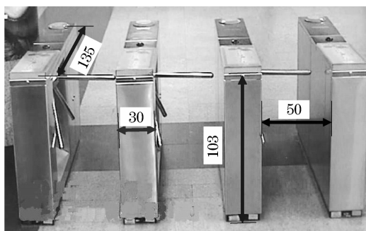
图2 闸机尺寸及布置示意图(单位:cm)
