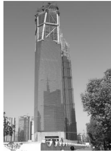
a 在建的上海 101 工程
