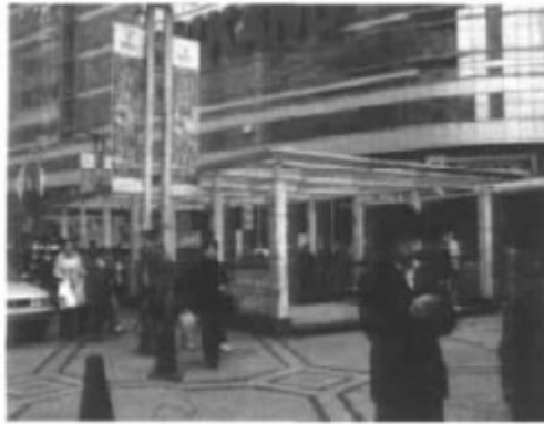
图2 轻轨临江门B1出入口
