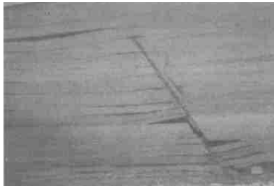
图 8 断层采动活化产生 Z 字形张拉断裂
