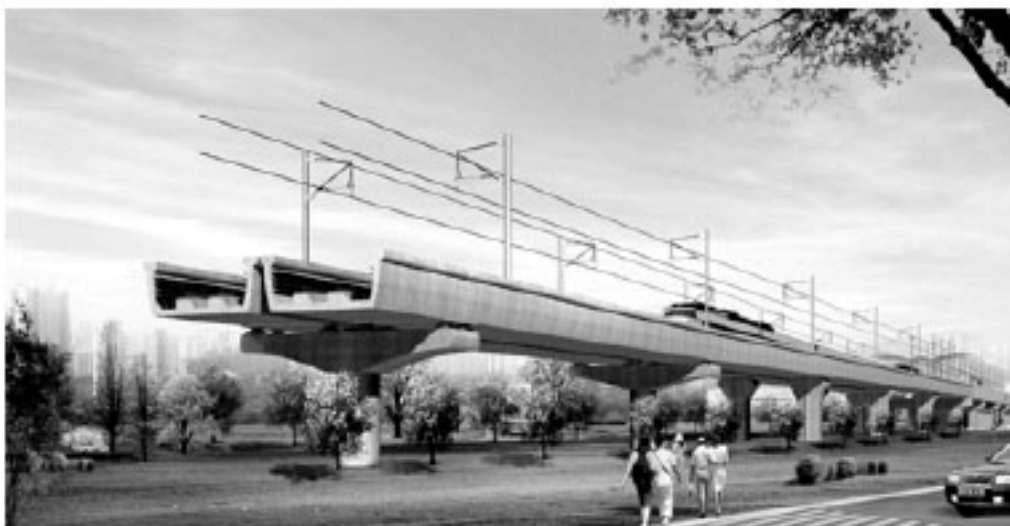
图 1 M8 线南延伸段“U”形梁
