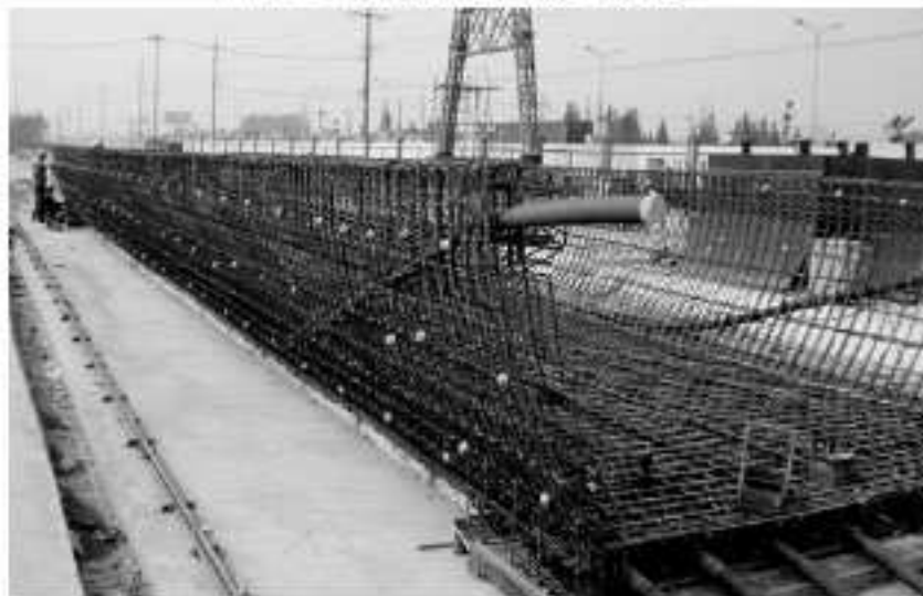
图 8 绑扎完毕的钢筋笼
