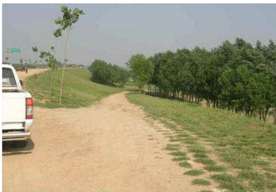
2005年8月17日大雨后，184+300处辅道完好情况
