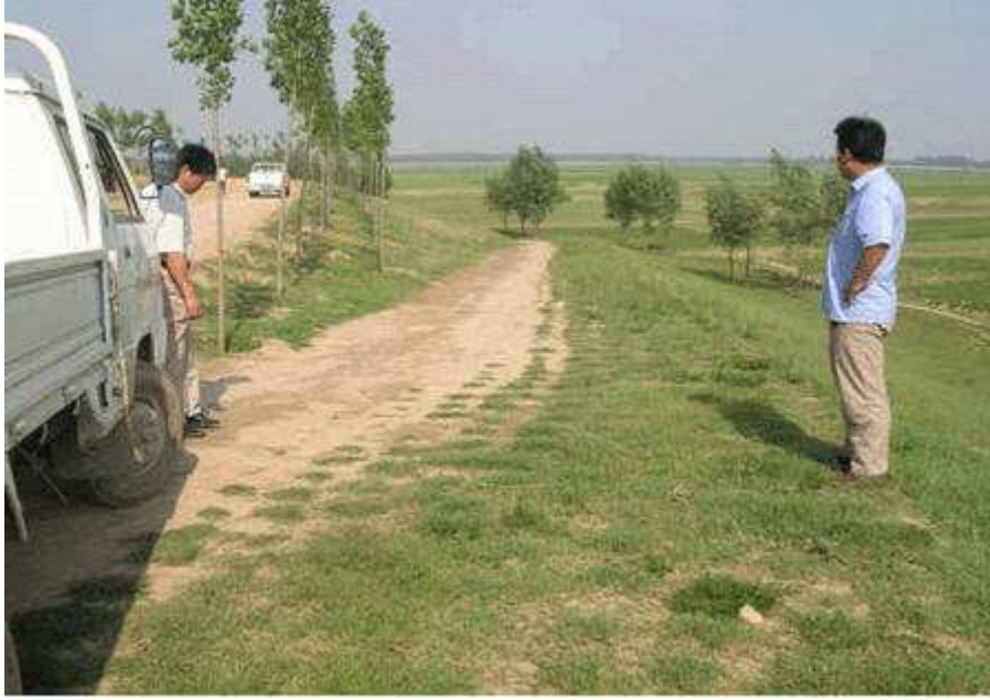
2006年7月31日大雨后，192+300处辅道完好情况
