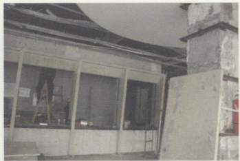
图2(c) 装修施工现场搭建的传统营业柜台现场施工搭建柜台
