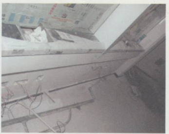
图2(b) 装修施工现场搭建的传统营业柜台综合布线
