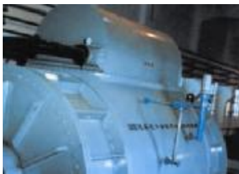
图1 50MW蒸发冷却汽轮发电机
