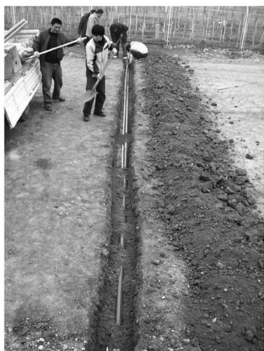
图 6 剖面沉降管埋设现场
