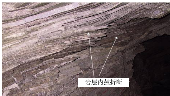
图 2 前期勘探平洞内岩层内鼓弯折现象
