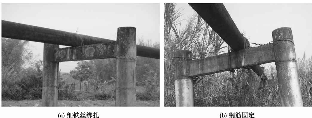
图 8 现场加固图
