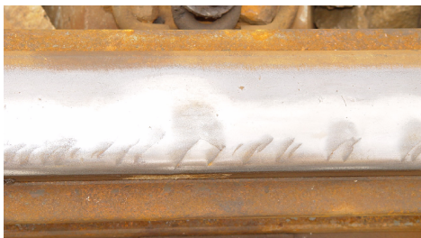
图1 钢轨表面斜裂纹
