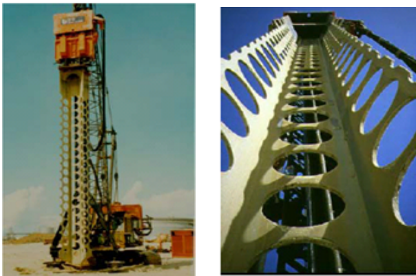
图1 砂性土深层竖向共振致密(Massarsch, 1991) (右为振动杆,杆顶为激振力大且轻便的高频振动锤)
