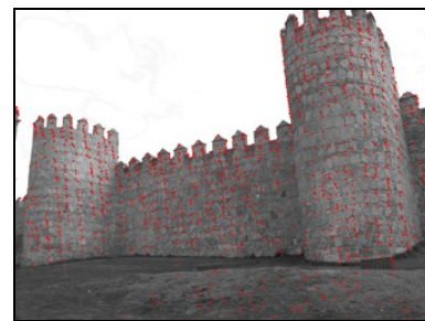
Figure 3. Förstner detector applied to medieval wall.
