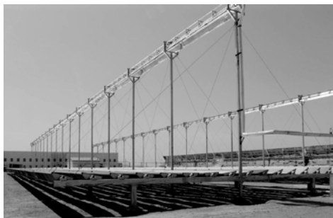
图4 线性菲涅尔式聚光系统图
