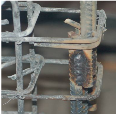
(a) 钢筋置换焊接示意图
