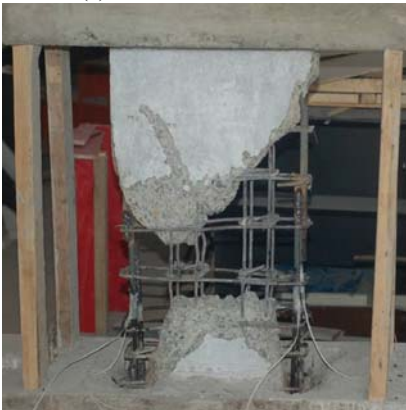
(b) 混凝土清除后的试件正面图
