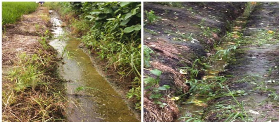
图1 研究区内排水沟的现状
