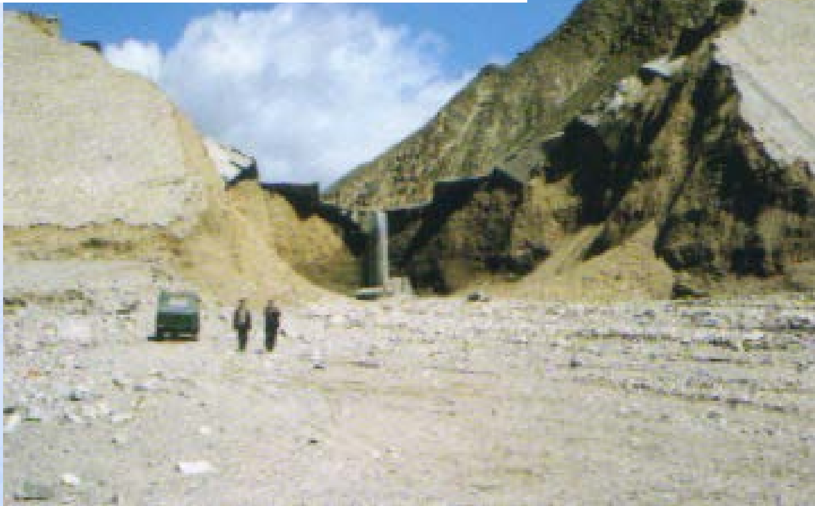
沟后混凝土面板堆石坝溃坝后的残留体
