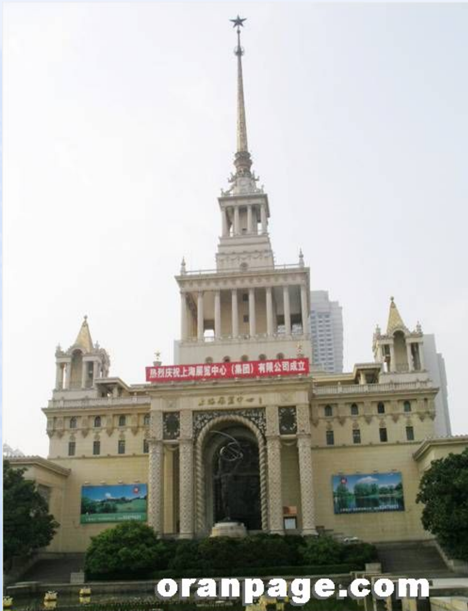
上海展览中心馆地基严重沉降
