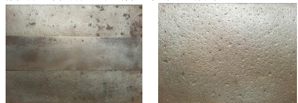
(a) 除锈后板材 (b) 除锈后板材表面锈坑
