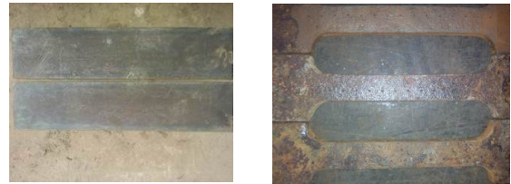
(a) 腐蚀前 (b) 腐蚀后
