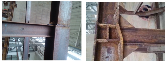
(a) 未锈蚀结构 (b) 锈蚀结构
